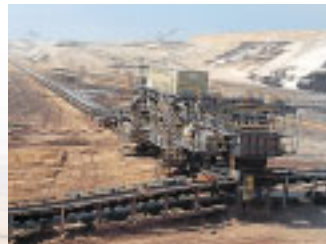
Bandantriebs- und Übergabestation
