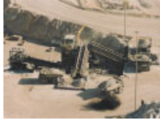
Semimobile „In-Pit Crushing“ Anlage
